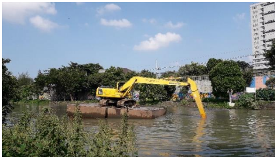
Gambar 4. 3 Pengerukan Endapan Sungai Kalimas di Badan Sungai Kawasan Pasar Bunga Kayoon
