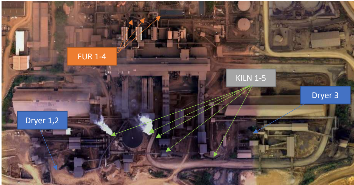
Gambar 4.3 Posisi stack yang ada di PTVI
