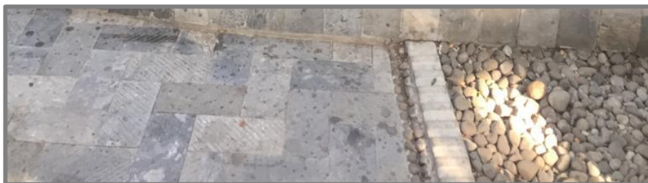
Gambar 2. 46 Dokumentasi Lantai Eksterior Hotel Resort Azana Sapta Nawa Sumber: Dokumentasi Penulis (2019)
