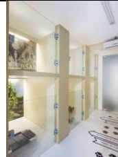
b. Kandang Anjing cubicle untuk menghemat space ruang dengan berdinding/pintu kaca untuk meminimalisir kerusakan yang diakibatkan dari gigitan maupun cakaran pasien
