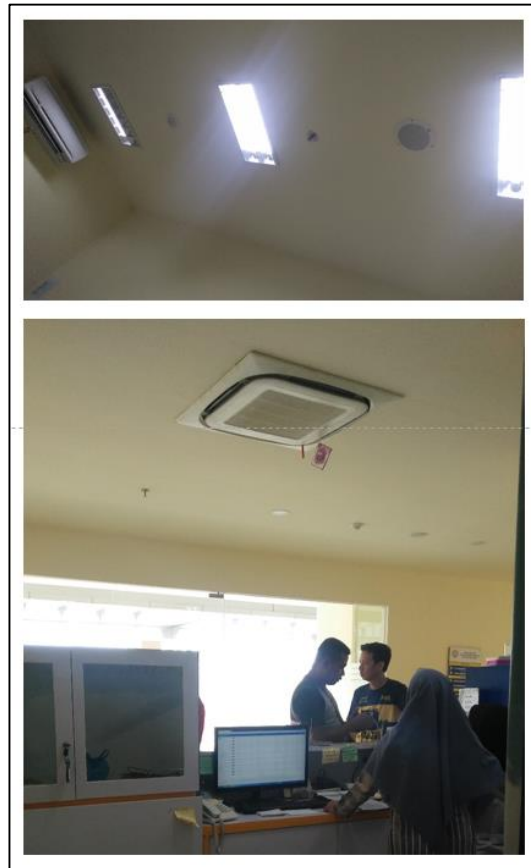
Gambar 4. 5 Jenis plafon yang digunakan di RSHP Unair
