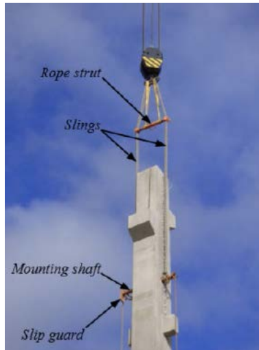
Gambar 4.3 Ilustrasi Pengangkatan Elemen Pracetak
