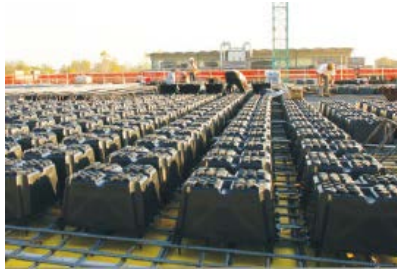
Gambar 2.8 Pemasangan U-Boot Tipe Single (Sumber: U-Boot Beton)
