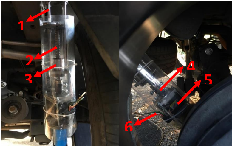
Gambar 4.11 Pemasangan RESA Tampak Belakang dan Tampak Samping
