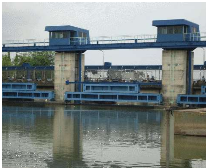
Gambar 4.6 Kondisi di Kawasan Jembatan Gunungsari
