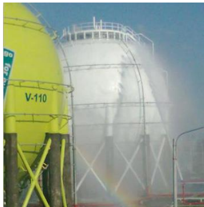
Gambar 2.3 Simulasi Penanganan Kebakaran pada Spherical Tank Sumber: https://www.opsico.co.id/
