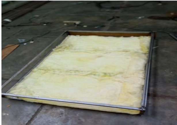
Gambar 3 8 Pemasangan Glass Woll pada Sisi Bawah Solar Collector Sumber : (dokumentasi pribadi)
