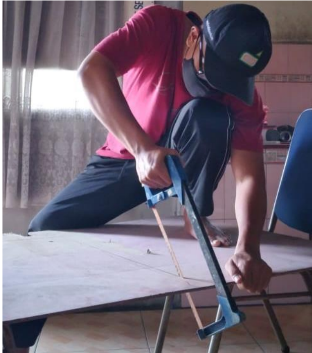
Gambar 4. 19. Tahap Pertama, Proses Pemotongan Triplek Sumber : Dokumentasi Pribadi
