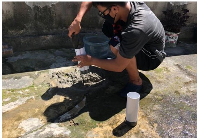
Gambar 4. 17. Proses Memasukkan Semen ke dalam 2 Buah Pipa PVC Sumber : Dokumentasi Pribadi
