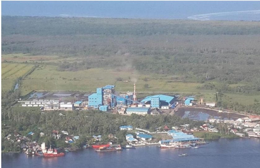
Gambar 2.2 PLTU dengan boiler tipe CFB
