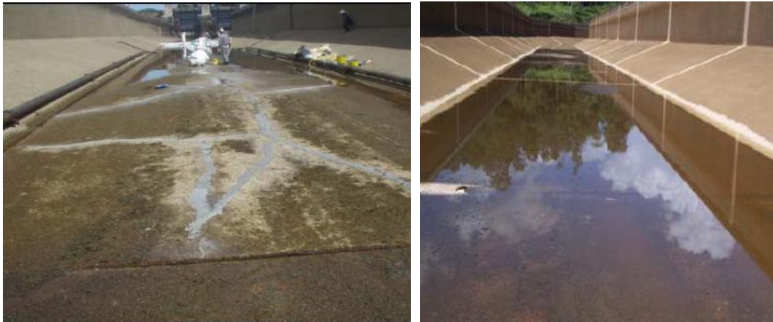
Gambar 2.28. Kondisi Larona Canal Setelah Perbaikan menggunakan Sikadur.
