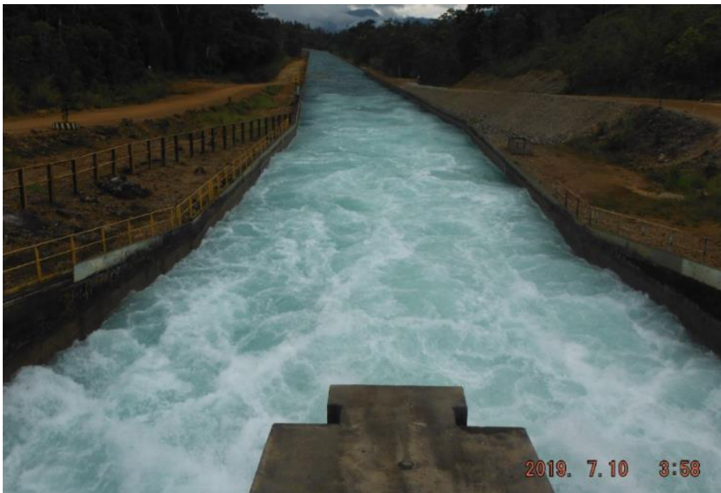
Gambar 4.2. Pembukaan Pintu Air canal intake ke posisi 150 cm pada jam 15.57 untuk mempertahankan 180 MW.
