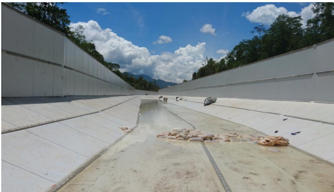
Gambar 2.29. Kondisi Larona Canal SETELAH dilakukan Canal Lining Menggunakan GFRD ( Geomembrane Face Rockfill Dam ).
