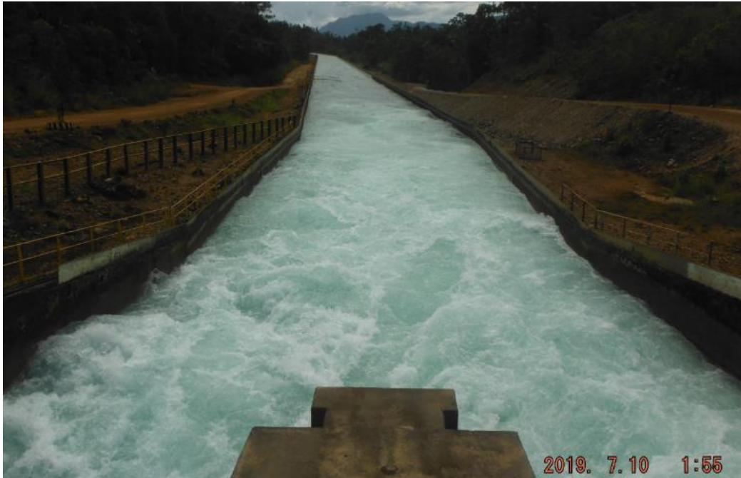
Gambar 4.1. Pembukaan Pintu Air Upper Canal (Canal Intake) dari 135 cm ke 140 cm pada jam 13.55.
