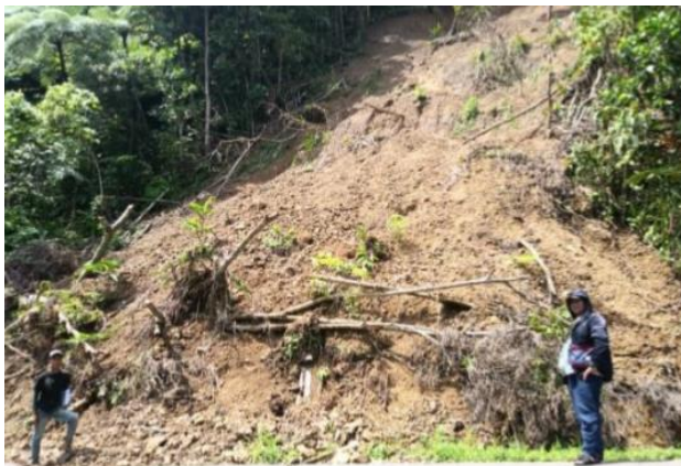
Gambar 1.4 Kondisi longsor di KM 8 (Sumber: PT. PLN (Persero))
