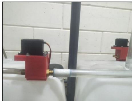
Gambar 3. 8 Pemasangan control valve
