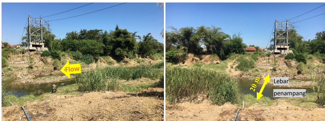
Gambar 4-46 Lokasi 1a jembatan runtuh akibat banjir Sungai Cisanggurung
