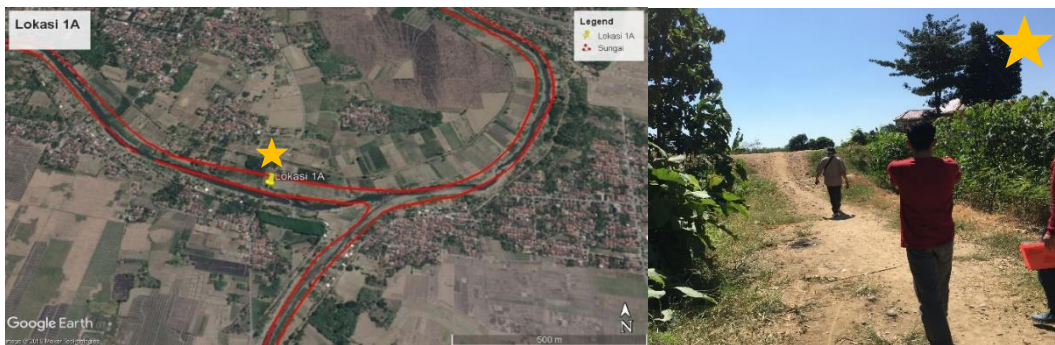
Gambar 4-45 Lokasi tanggul yang mengalami banjir
