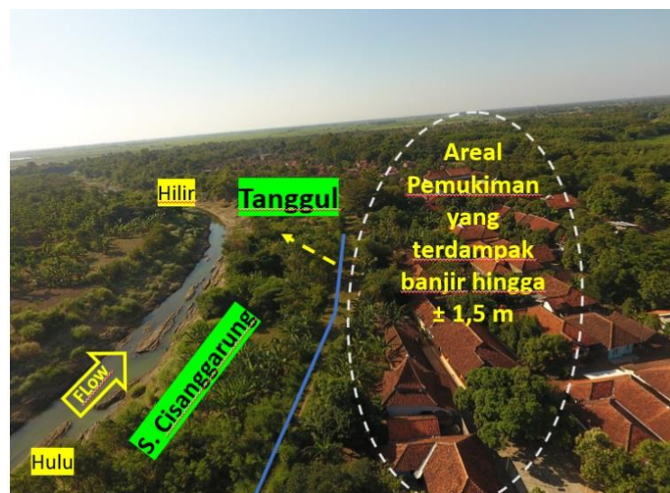
Gambar 4-56 Banjir pada lokasi 4 meluap melewati tanggul
