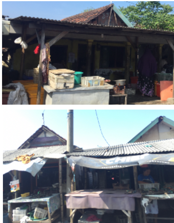
Gambar 4.6 Kondisi Fisik Rumah di Permukiman Nelayan Tambak Cemandi
