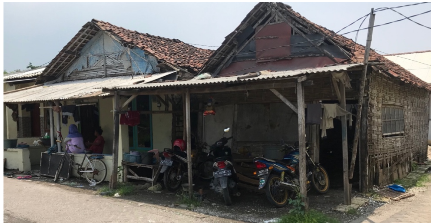
Gambar 4.7 Kondisi Keselamatan Bangunan Rumah di Permukiman Nelayan Tambak Cemandi
