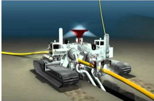
Gambar 4.21 Post Trenching (Sumber : [13] Perlindungan Pipa Bawah Laut)
