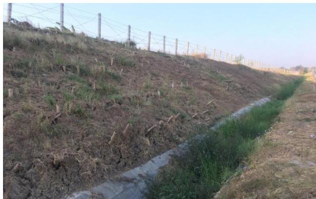
**Gambar 1. 5** Sisi lereng yang terpasang cerucuk bambu
