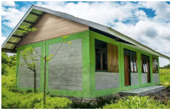
Gambar 2. 9 Aplikasi ruspin pada rumah satu lantai Sumber: BALITBANG PUPR,2013
