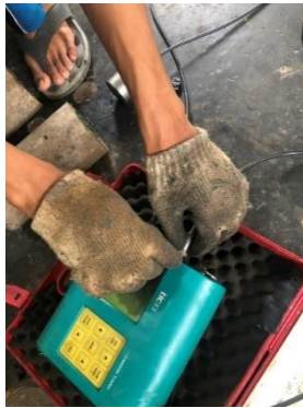
Gambar 3. 7 pemasangan kabel UPV
