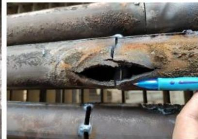
*Gambar titik Kebocoran dan penggantian tube*
