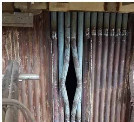
**Gambar 2. 2** Waterwall tube pembangkit listrik tenaga uap pada daerah Sootblower
