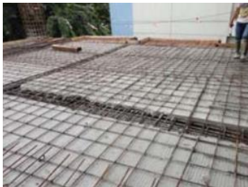
Gambar 2. 18 Pemasangan Tulangan Overtopping
