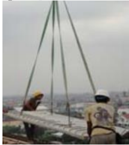
Gambar 2. 15 Gambar Pengangkatan Pelat
