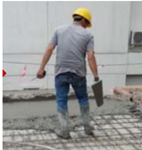
Gambar 2. 19 Pengecoran Balok dan Overtopping Pelat
