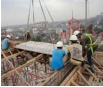
Gambar 2. 16 Pemasangan Pelat Precast
