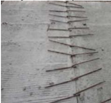
Gambar 2. 17 Overstek Tulangan Pelat Precast
