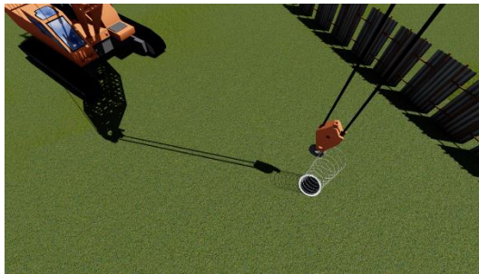
Gambar 5.51 Pemasangan Tulangan dengan bantuan Mobil Crane
