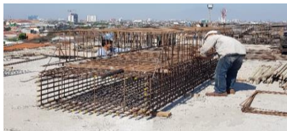
Gambar 5. 6 Fabrikasi Tulangan Kolom (Sumber: Dokumen Pribadi)
