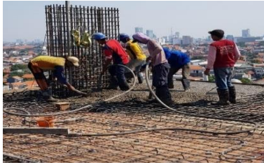
Gambar 5. 10 Pengecoran Balok (Sumber: Dokumen Pribadi)
