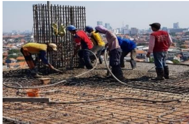
Gambar 5. 12 Pengecoran Pelat Lantai
