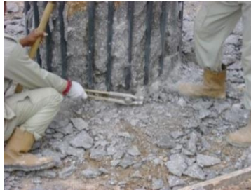
Gambar 5. 3 Pembobokan Kepala Bore Pile
