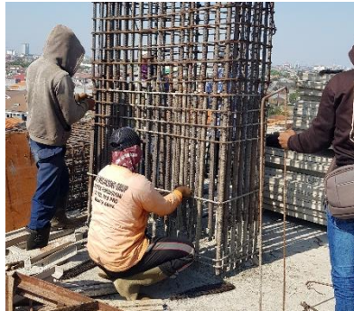
Gambar 5. 7 Pemasangan Tulangan Kolom
