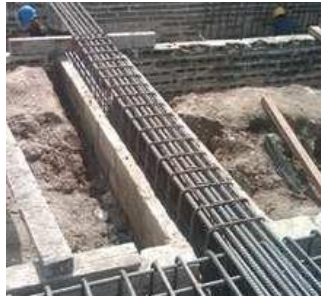
Gambar 5. 5 Pemasangan Bekisting pada Tie Beam (Sumber: www.ilmutekniksipil.com/ [Diakses pada 23 Maret 2020])
