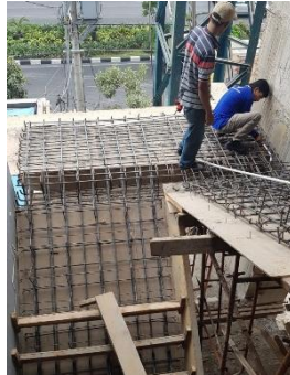
Gambar 5. 14 Pemasangan Tulangan Tangga (Sumber: Dokumen Pribadi)
