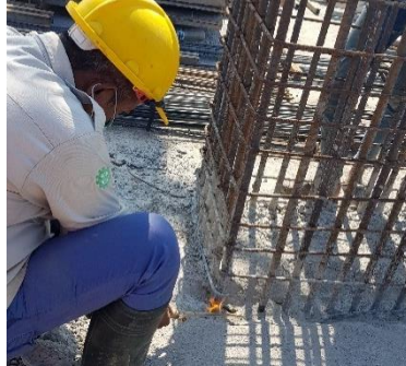
Gambar 5. 8 Marking kolom sebagai tempat bekisting (Sumber: Dokumen Pribadi)
