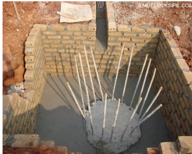
Gambar 5. 4 Pemasangan Bekisting pada Pile Cap
