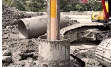
Gambar 5. 1 Pengeboran dan Pemasangan Temporary Casing (Sumber: www.graha_pondasi.com/ [Diakses pada 23 Maret 2020])
