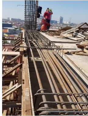
Gambar 5. 9 Pemasangan Tulangan Balok (Sumber: Dokumen Pribadi)
