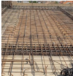
Gambar 5. 11 Pemasangan Tulangan Pelat (Sumber: Dokumen Pribadi)
