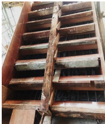
Gambar 5.19 Pekerjaan Pemasangan Bekisting pada Anak Tangga (Sumber: Dokumentasi Pribadi)
