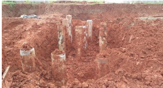
Gambar 5.3 Galian Pile Cap (Sumber: Dokumentasi Perusahaan)
