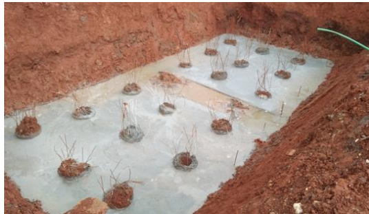
Gambar 5.4 Lantai Kerja Pile Cap (Sumber: Dokumentasi Perusahaan)
