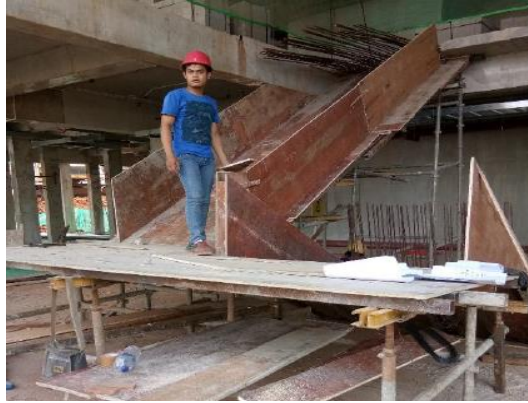
Gambar 5.18 Pekerjaan Pemasangan Bekisting Tangga (Sumber: Dokumentasi Pribadi)
