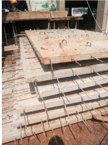
Gambar 2.1 Pelat Precast (Sumber: Dokumentasi Pribadi)
