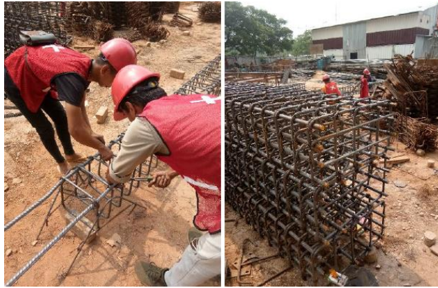
Gambar 5.6 Perakitan Tulangan Kolom (Sumber: Dokumentasi Pribadi)
