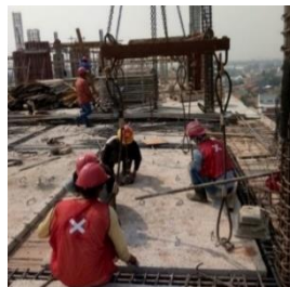
Gambar 5.15 Pemasangan Pelat Precast (Sumber: Dokumentasi Pribadi)
