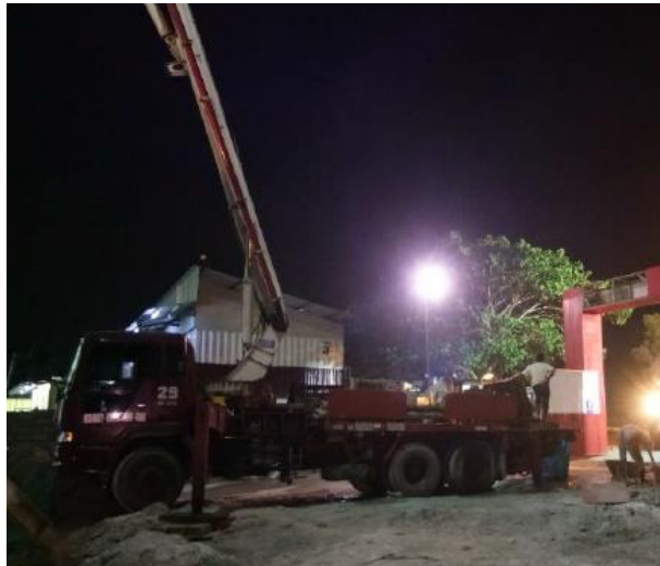
Gambar 2.13 Concrete Pump (Sumber: Dokumentasi Pribadi)
