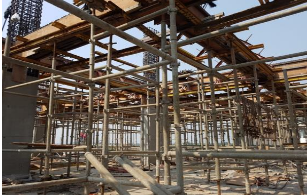
Gambar 5.12 Scaffolding sebagai Penyangga (Sumber: Dokumentasi Pribadi)
