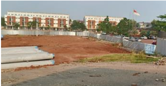
Gambar 5.2 Pancang on Site (Sumber: Dokumentasi Perusahaan)
