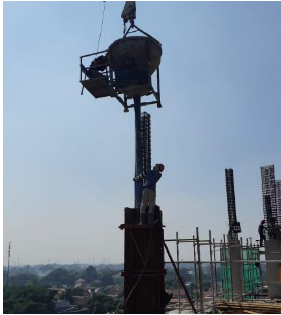
Gambar 5.10 Pekerjaan Pengecoran Kolom (Sumber: Dokumentasi Pribadi)
