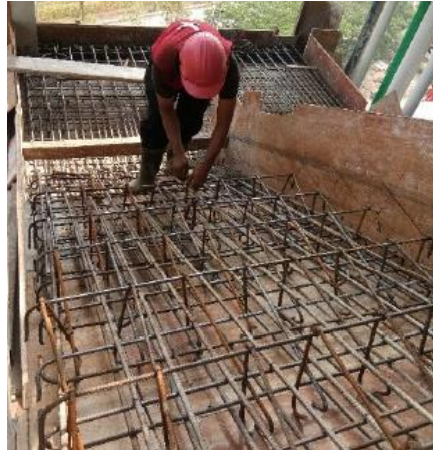
Gambar 5.21 Pekerjaan Pembesian Anak Tangga (Sumber: Dokumentasi Pribadi)
