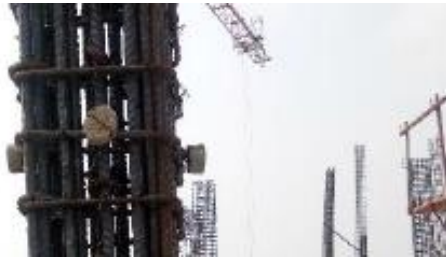
Gambar 5.8 Beton Decking pada Struktur Kolom (Sumber: Dokumentasi Pribadi)
