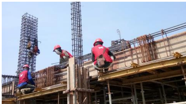
Gambar 5.13 Pekerjaan Pembesian Balok (Sumber: Dokumentasi Pribadi)
