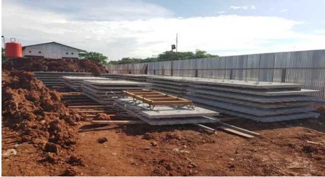
Gambar 5.14 Penumpukan Pelat Precast ( Sumber: Dokumentasi Perusahaan )
