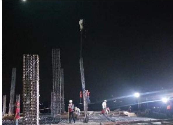
Gambar 5.7 Pemasangan Tulangan Kolom (Sumber: Dokumentasi Pribadi)
