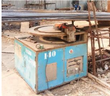
Gambar 2.15 Bar Bender (Sumber: Dokumentasi Pribadi)
