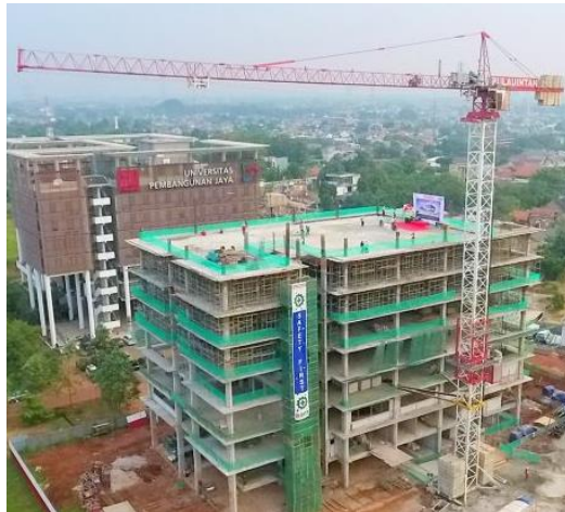
Gambar 2.11 Tower Crane (Sumber: Dokumentasi Perusahaan)
