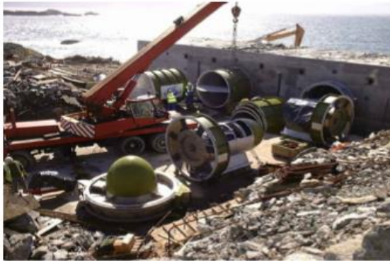
Gambar 2. 18 Proses pemasangan orifice . [8]
