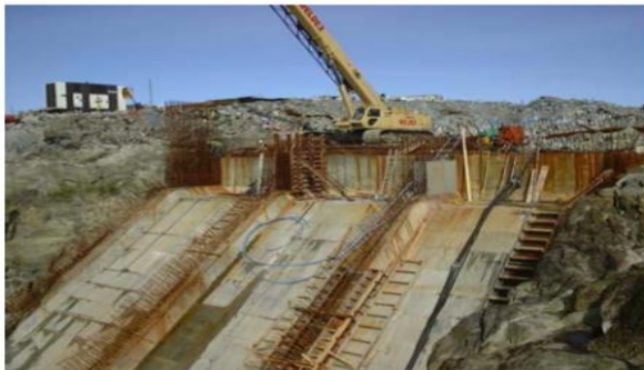
Gambar 2. 15 Proses pengecoran setelah pengerukan. [8]
