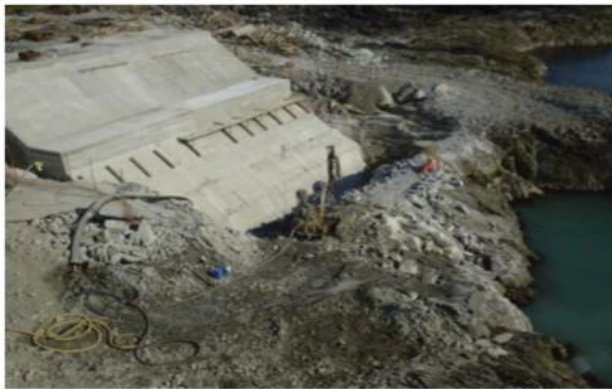
Gambar 2. 17 Proses penutupan dengan pengecoran. [8]
