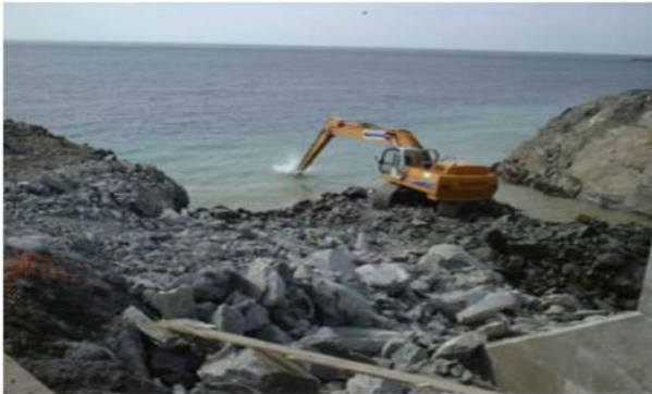
Gambar 2. 19 Proses penghancuran tembok penghalang. [8]
