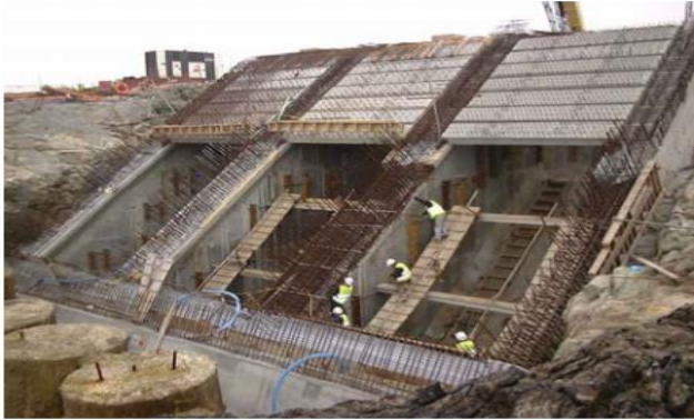
Gambar 2. 16 Proses pemasangan balok beton. [8]
