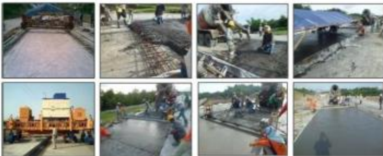
Gambar 4. 22 Pekerjaan Concrete paver dan finishing
