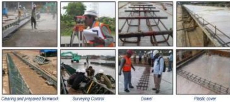
Gambar 4. 21 Pekerjaan Survei dan pemasangan dowel
