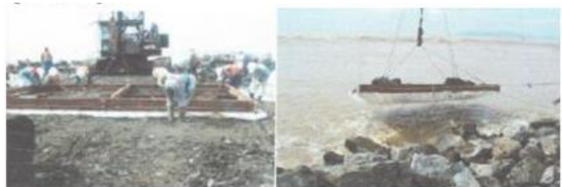
Gambar 2. 20 Pemasangan Geotextile
