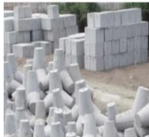
d. Blok beton 1 \times 1 \times 1 dan 1,7 \times 1,7 \times 1,7
