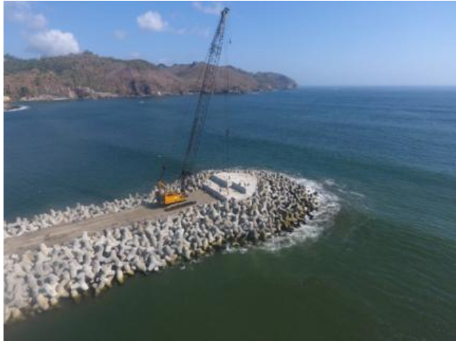
Gambar 2. 12 Kondisi Pembangunan Groin pada saat ini di STA +500 (99,...% hampir selesai)
