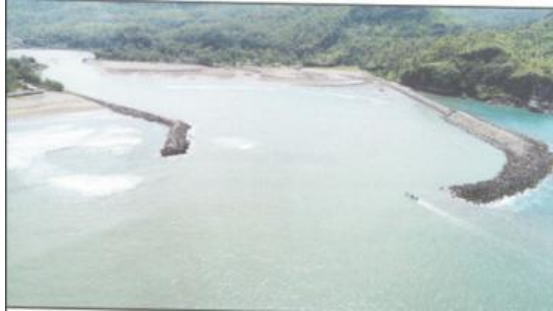
Gambar 2. 21 Lokasi Pekerjaan Muara (Pengerukkan Alur Pelayaran)
