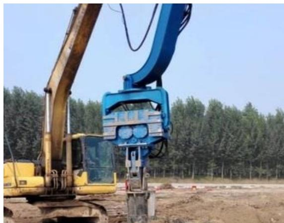
**Gambar 4. 8. Illustrasi Pemancangan Tiang Pancang Diameter 30 cm**
