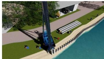
**Gambar 4. 12. Ilustrasi Pemasangan CCSP Di Area Tanggul Waduk**
