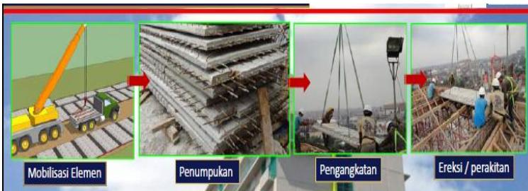
Gambar 2. 7 Proses Pekerjaan Half Slab
