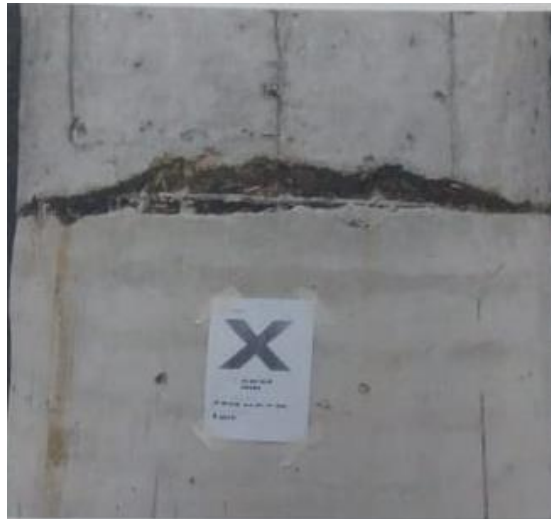
Gambar 1.3 Keropos pada kolom struktur
