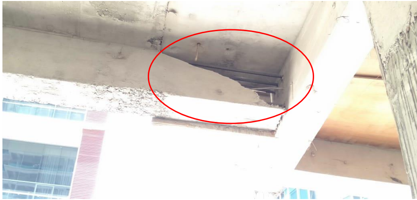
Gambar 1.2 Keropos pada balok struktur
