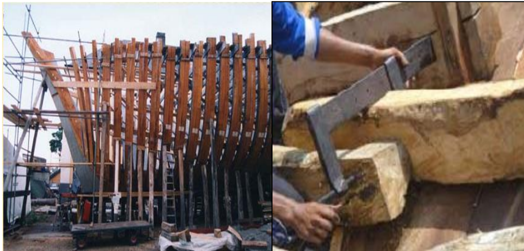
Gambar 1. 1 Konstruksi Gading dan Ukuran Balok Kayu
