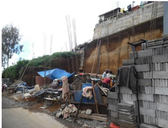
Gambar 3.5 Pembangunan rumah tinggal di Desa Ranupane menggunakan material dinding batako
