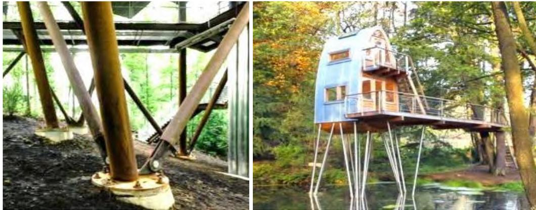
Gambar 2.5 Penerapan sistem *stilts* pada rumah pohon (inhabitat.com)
