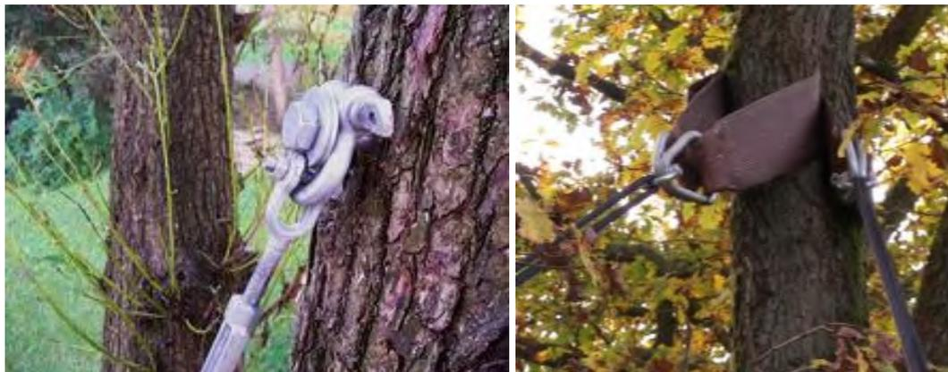
Gambar 2.6 Detail sistem *stay rods* pada rumah pohon (designrulz.com)
