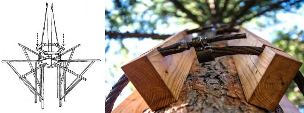
Gambar 2.7 Sistem *Friction* pada rumah pohon (thetreehouseguide.com)
