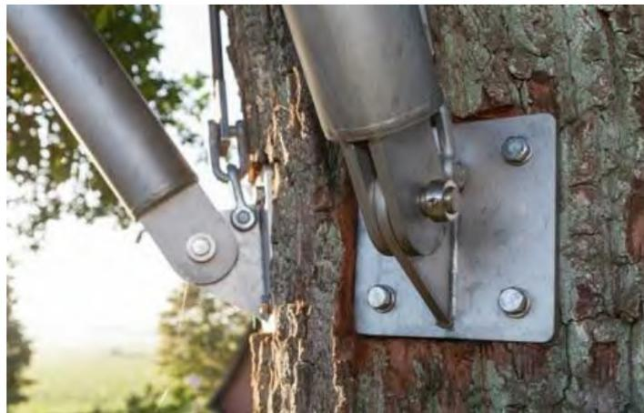
Gambar 2.4 Contoh sistem struts untuk menyalurkan beban platform (inhabitat.com)
