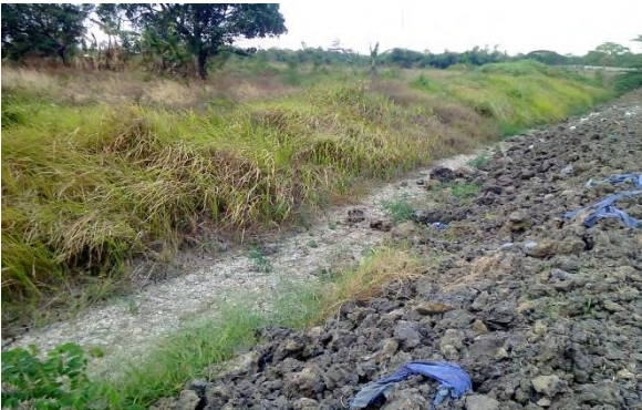
Gambar 4.3. Outlet saluran pembuang (saluran Baru)
