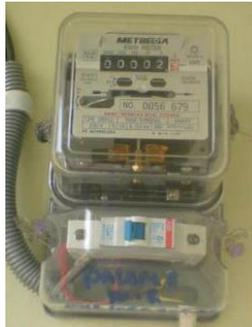
**Gambar 2.1.** KWH Meter Analog
