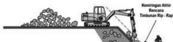
Gambar 4.69 Penataan material Rip Rap di lokasi
