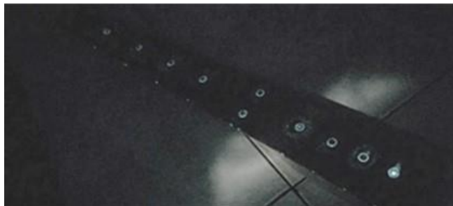
Gambar 5.0.29 Resin phosphor akan bekerja ketika terserap cahaya sebelum di kondisi gelap (Sumber : Penulis, 2020)
