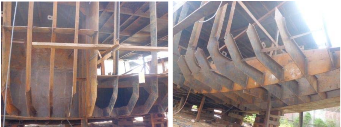
Gambar 4.2 Proses Pembangunan Kapal Tug Boat
