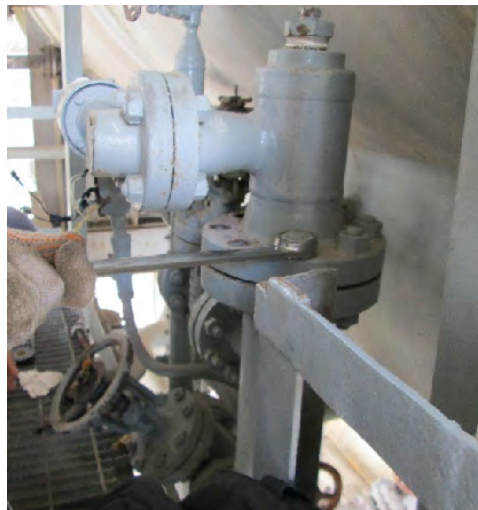
Gambar 2. 8 Displacer pada Surface Condensor
