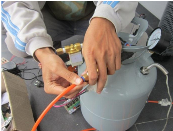
Gambar 6.8 Pemasangan pipa pada tabung kalibrasi.
