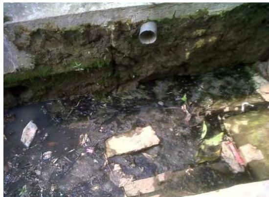
Gambar 3.3 Outlet langsung dibuang ke saluran drainase
