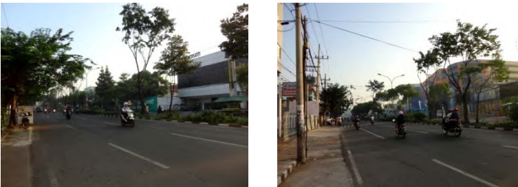
Gambar 3. 8 Kondisi RTH Jalur Hijau Jalan di Jl. Kusuma Bangsa
