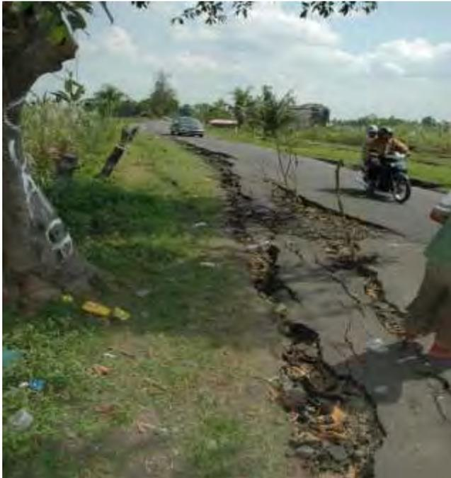
Gambar 2.11 Deformasi berupa retak pada jalan raya yang diakibatkan oleh gempa bumi di Yogyakarta pada tahun 2006 dengan kekuatan 6,2 skala Richter
