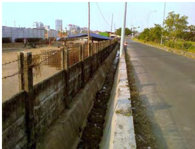
Gambar 4.1 Saluran Tepi Jalan Tol Waru - Juanda
