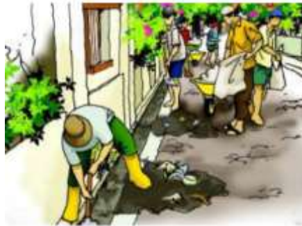
Gambar VI.14 Pengangkatan sedimen di saluran
