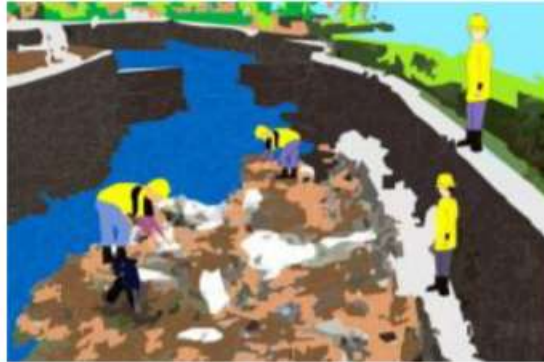
Gambar VI.18 Kegiatan pembersihan sedimen pada bangunan terjun
