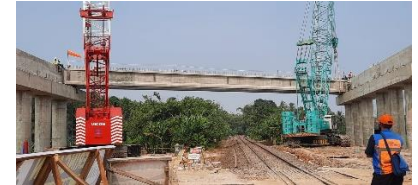
Erection PCI girder di atas rel kereta api
