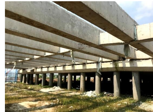
Gambar balok joint dan diafragma setelah dicor
