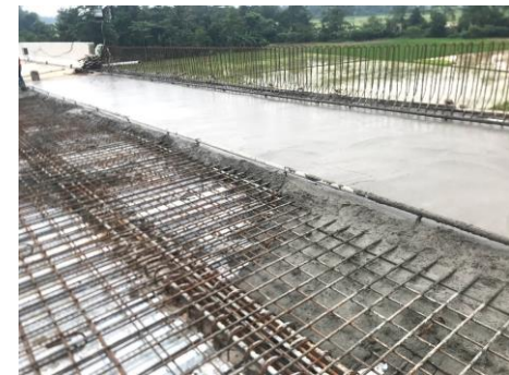
Slab setelah diratakan
