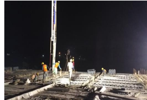
Pengecoran diafragma dan balok joint
