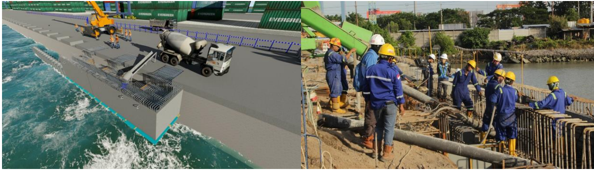
Gambar 2. 40 Ilustrasi Pengecoran Capping Beam Tahap 1 (Sumber : Data Perusahaan)
