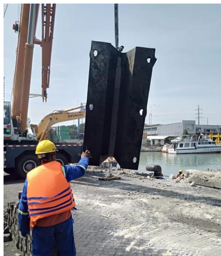
Gambar 2. 10 Pengangkutan fender (Sumber : Data Perusahaan)
