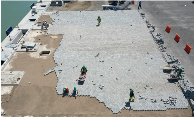
Gambar 2. 61 Ilustrasi Pemasangan Paving (Sumber : Data Perusahaan)
