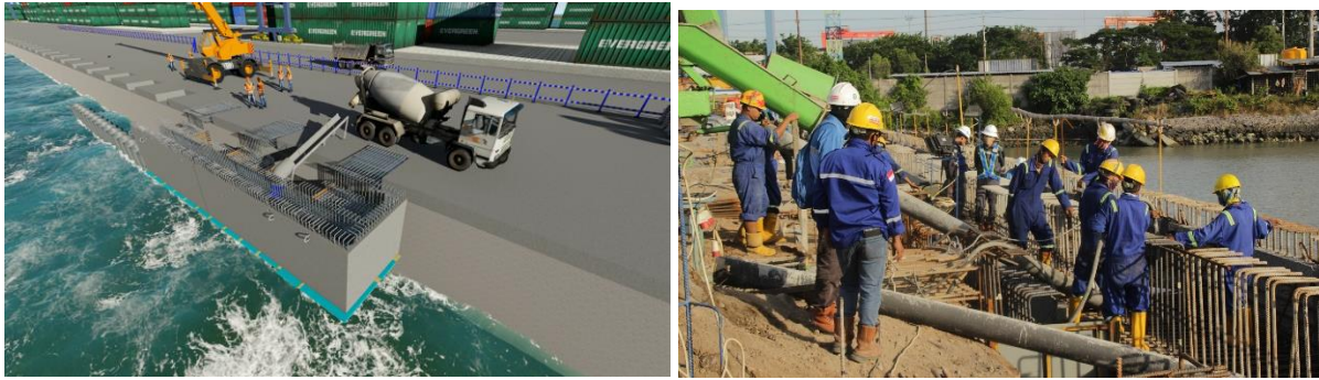
Gambar 2. 46 Ilustrasi Pengecoran Capping Beam Tahap 2 (Sumber : Data Perusahaan)
