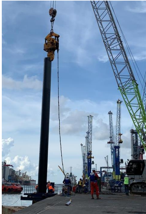
Gambar 2. 15 Ilustrasi Positioning Tiang Pancang Pada Guide Beam (Sumber : Data Perusahaan)
