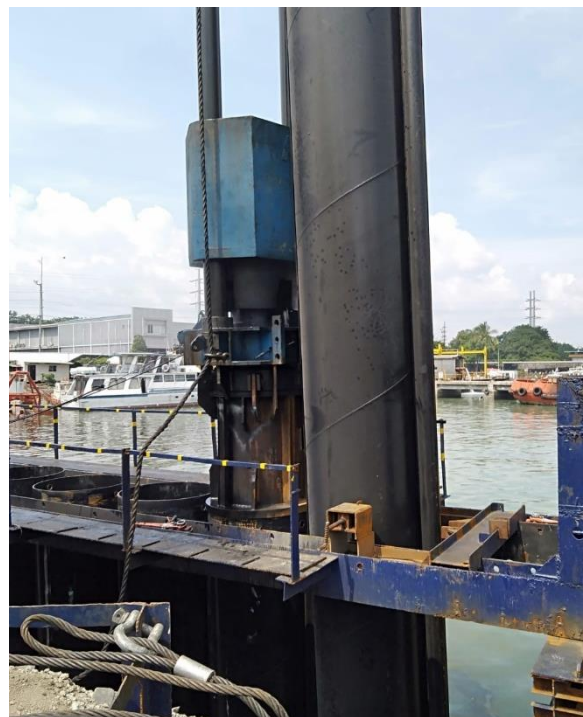
Gambar 2. 16 Ilustrasi Pemancangan dengan Diesell Hammer (Sumber : Data Perusahaan)
