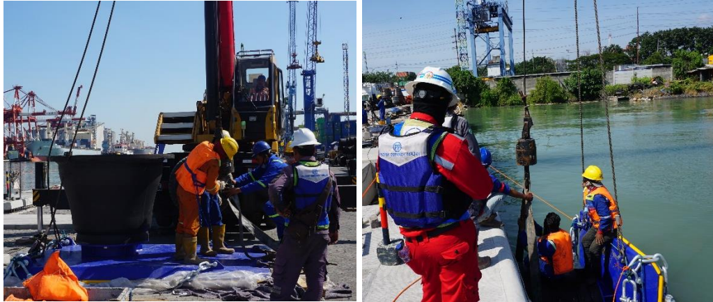
Gambar 2. 50 Ilustrasi Pemasangan Fender (Sumber : Data Perusahaan)
