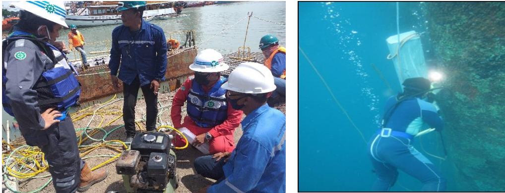
Gambar 2. 54 Ilustrasi Pemasangan Cathodic (Sumber : Data Perusahaan)
