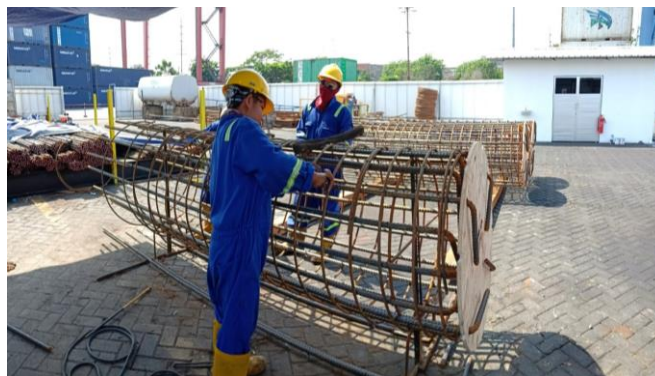
Gambar 2. 20 Pembesian dan Bekisting Isian Tiang Pancang (Sumber : Data Perusahaan)
