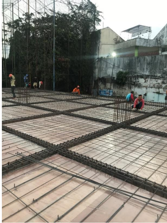
Gambar 3. 28 Pemasangan Tulangan Plat
