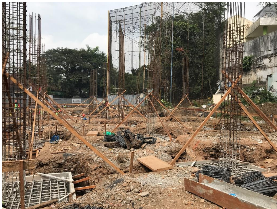
Gambar 3. 16 Tulangan Kolom yang telah Terpasang
