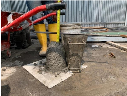
Gambar 3. 20Pemeriksaan Slump Test pada Pesanan Beton Ready Mix
