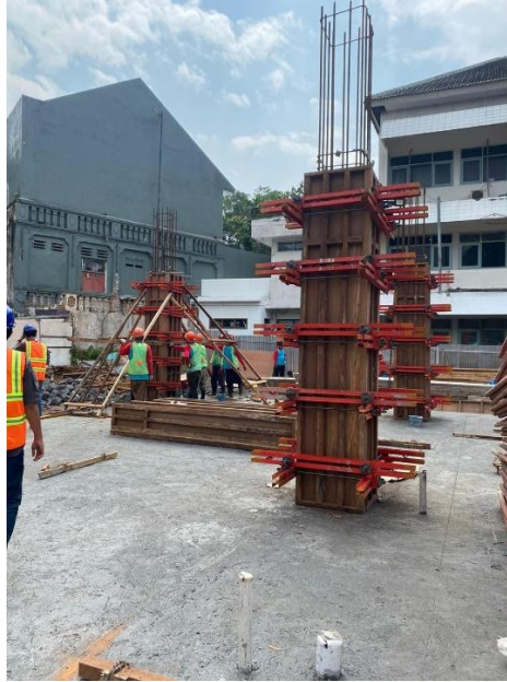
Gambar 3. 19 Bekisting Kolom yang Sudah Terpasang
