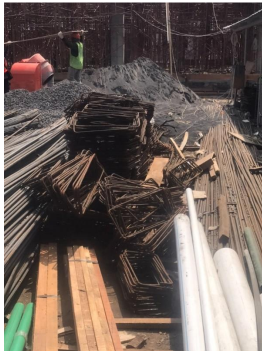
Gambar 3. 15 Besi Tulangan yang telah Dipotong dan Dibengkokkan
