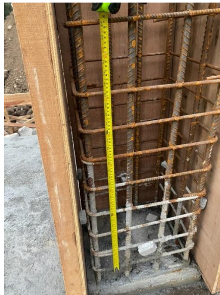
Gambar 3. 18 Pengecekan QC pada Tulangan Kolom
