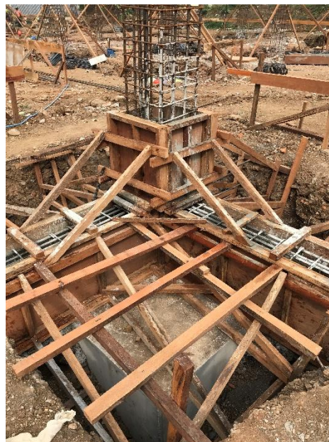
Gambar 3. 14 Pile Cap yang Sudah Terinstall Sloof
