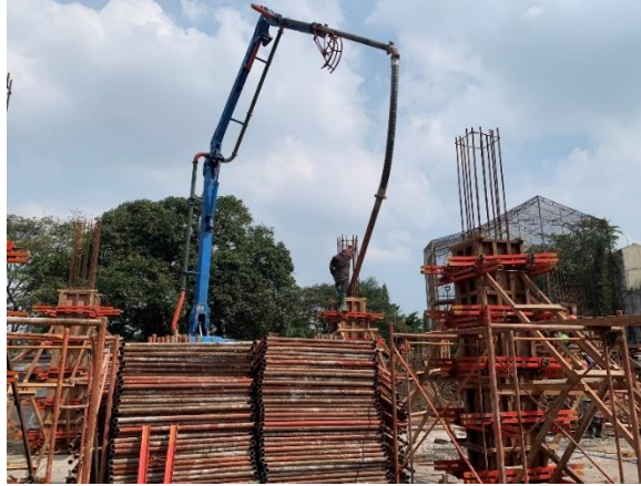
Gambar 3. 21 Proses Pengecoran Kolom
