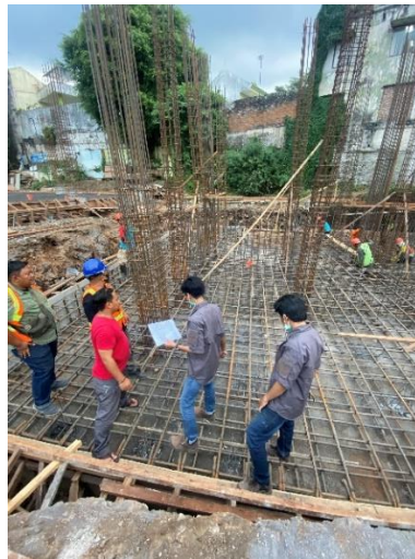
Gambar 3. 12 Install Pembesian Pile Cap
