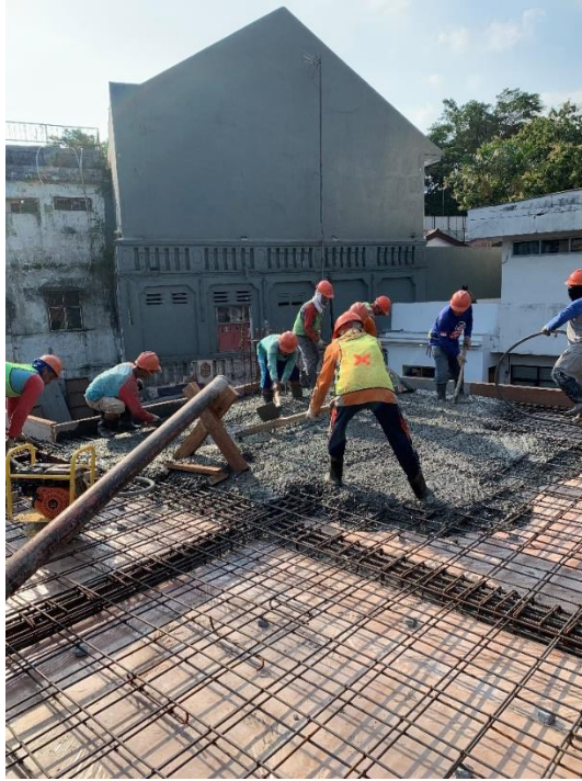
Gambar 3. 30 Proses Pengecoran Balok dan Plat
