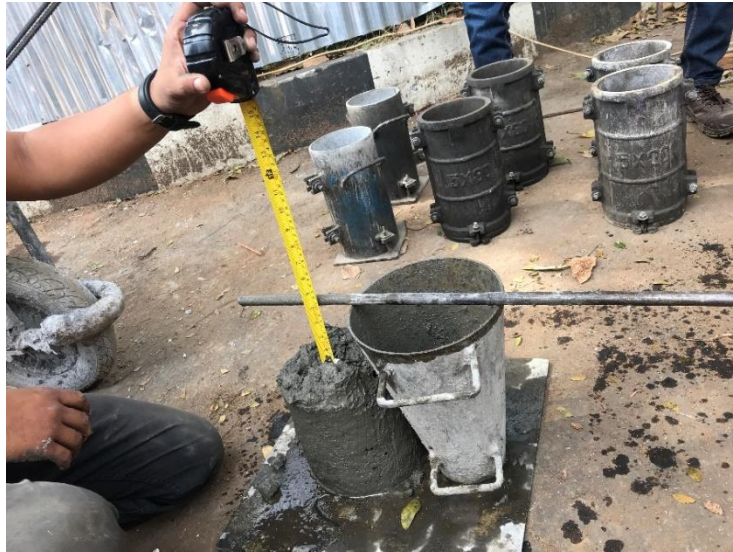
Gambar 3. 29 Pemeriksaan Slump Test pada Pesanan Beton Ready Mix
