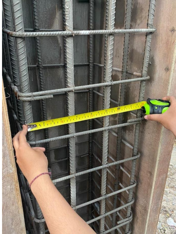
Gambar 5. 2 Quality Control Pekerjaan Pembesian
