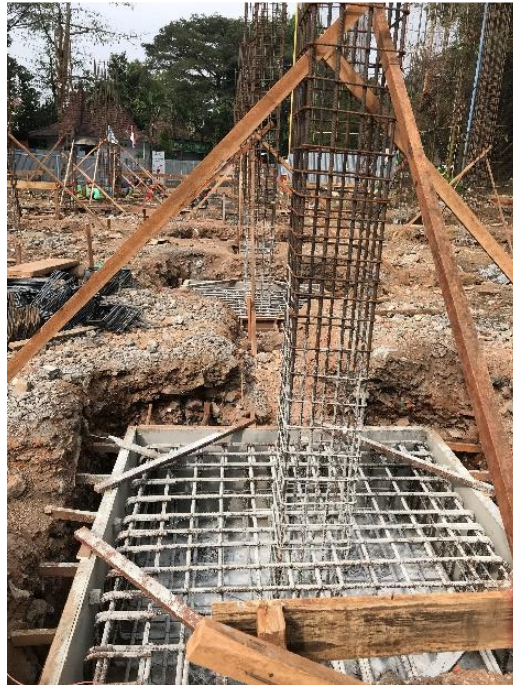
Gambar 3. 13 Pile Cap yang Siap Dicor
