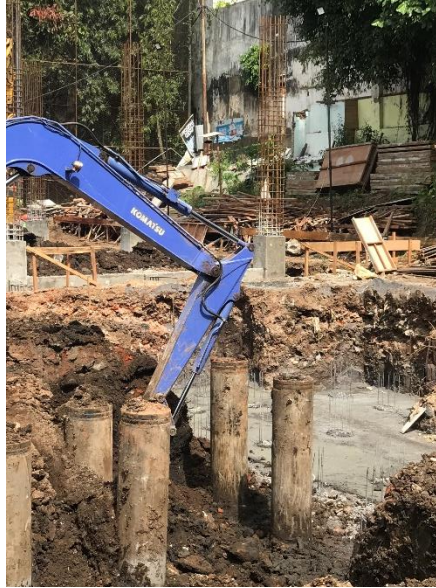
Gambar 3. 11 Proses Pemecahan Kepala Tiang Pancang
