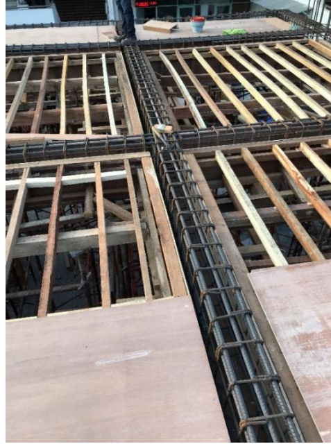
Gambar 3. 27 Pemasangan Bekisting Plat
