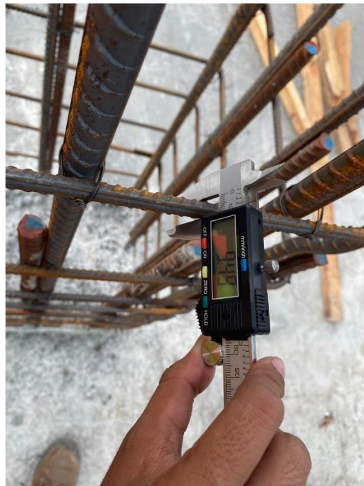
Gambar 5. 4 Quality Control Pekerjaan Pembesian
