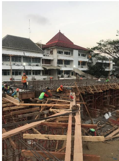
Gambar 3. 26 Pemasangan Girder Kayu
