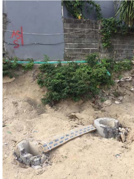
Gambar 5.4 Titik Pancang yang Dekat dengan Bangunan Sekitar
