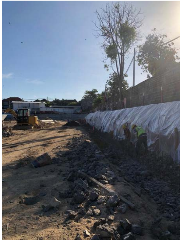
Gambar 4.7 Pembobokan Kepala Sheetpile
