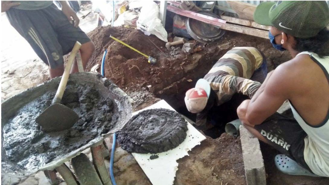
Gambar 3.11 Pembuatan Bak Penampungan
