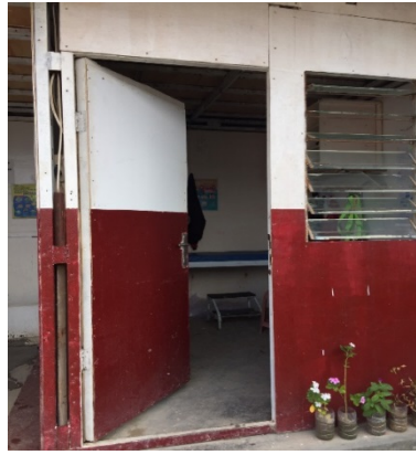
Gambar 2.7 Ruang Keselamatan dan Kesehatan Kerja
