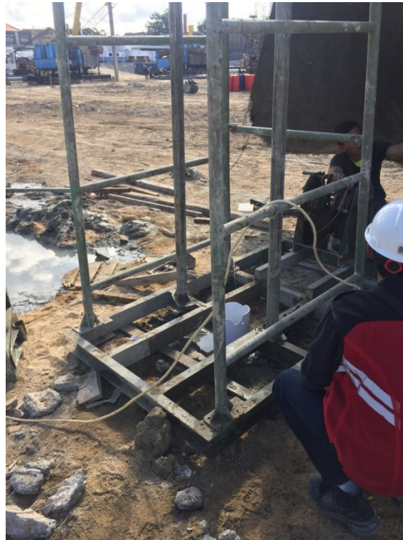
Gambar 4.13 Proses Pembuatan Titik Dewatering
